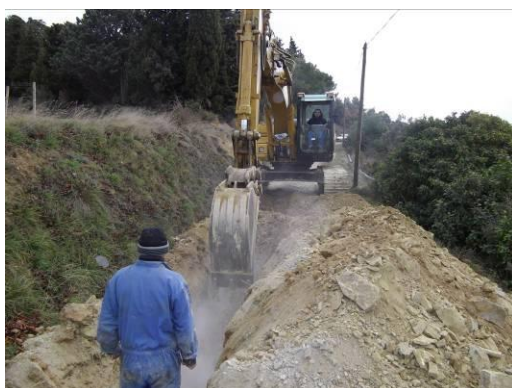
Les travaux sont réalisés par l'entreprise Oulès
