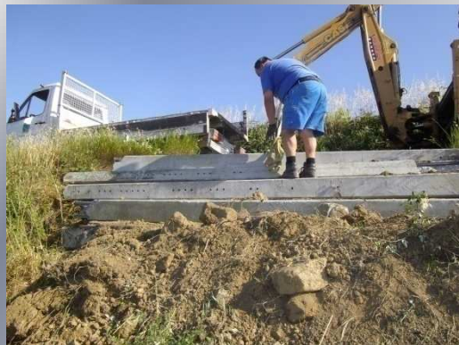
Réfection d'un éboulement chemin de Montplasilir
