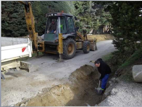
Travaux Chemin Pech de Gouzenne
