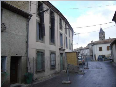
Rénovation de l'ancien bureau de poste
