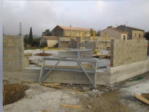
Construction de l'école
