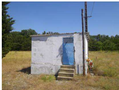
Puits « Cantier » au Thou
